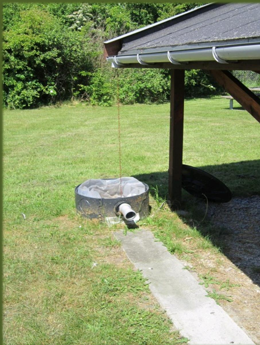
Regnvandstønden får regn fra demoskuret og sender vandet videre til regn bedet via en beton rende og græslavning.
