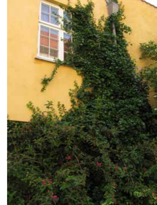
Eksempel der viser en Efeu, som kræver beskæring for ikke at skade bygningen.
